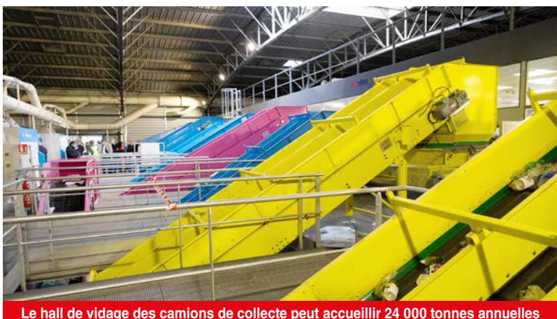
Le hall de vidage des camions de collecte peut accueillir 24 000 tonnes annuelles
