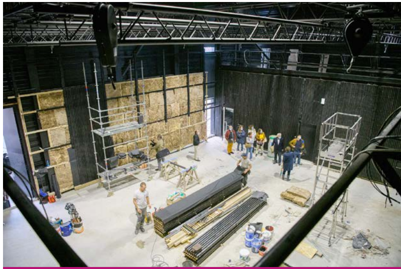
Certains travaux sont terminés, d'autres sont encore en cours (© Thierry Laporte/Ville de Limoges)
