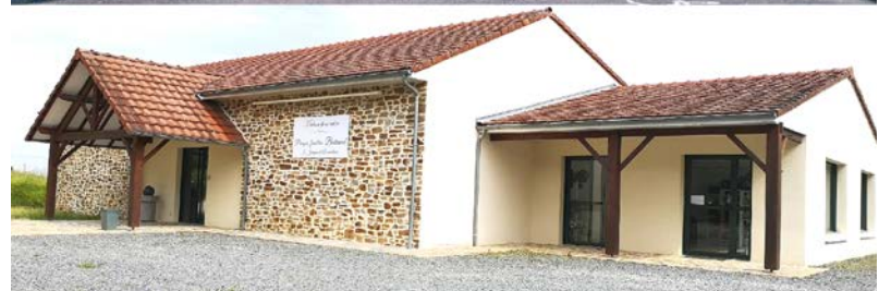
Les pompes funèbres Barraud sont situées à Nexon ainsi qu'à Saint-Yrieix-la-Perche
